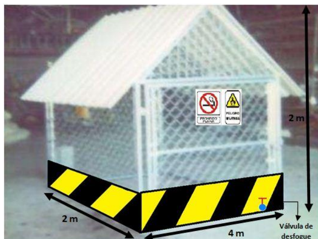
Figura: Bodega para combustibles con cubeto incorporado
